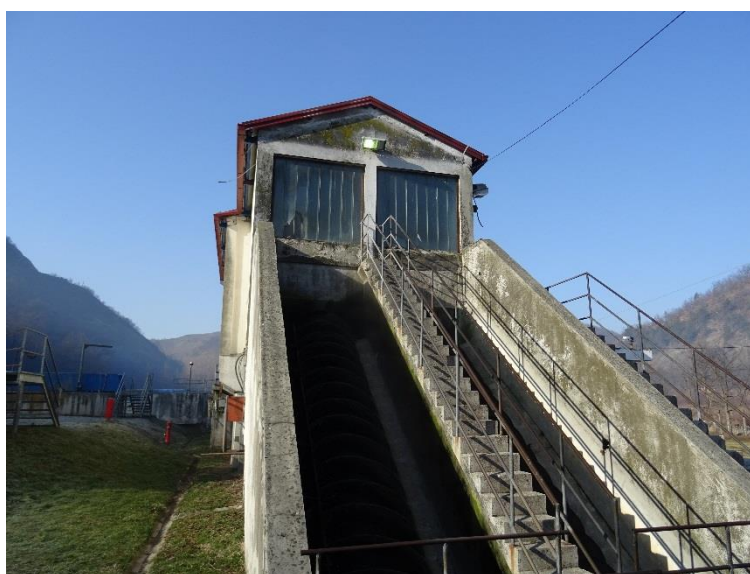
Пужне пумпе на улазу у постројење
