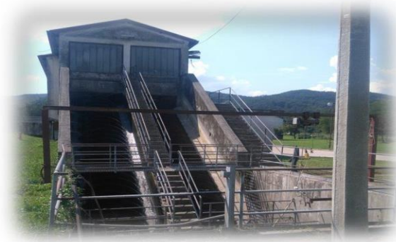
Пужне пумпе на улазу у постројење
